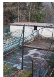
Il depuratore di Montecampione
